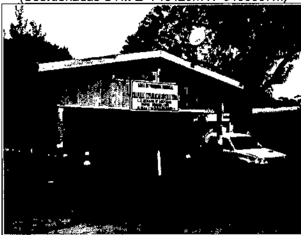
FOTO 03 – Escritório da empresa Chapleau no acampamento (Coordenadas UTM E=715484m N=9166653m)
