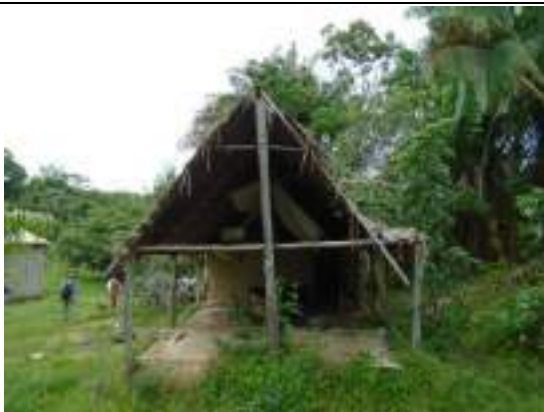
Foto 09: Exemplo de construção de madeira e cobertura de palha na Terra Vista Alegre (25/01/2019).
