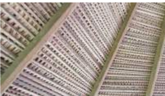
Foto 24: Telhado da casa do guerreiro na aldeia Guary-Duan, feito com castanheira e olho da palha de babaçu.
