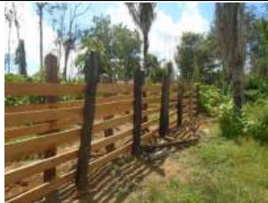
Foto 08: Curral de castanheira sendo construído na aldeia Itkoum durante a campanha de verão (18/07/2019).
