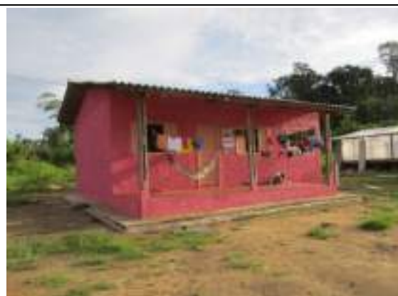
Foto 04: Residência – aldeia Terrawangã (23/01/19).
