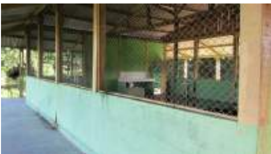
Foto 37: Vista lateral da Casa de Farinha existente na aldeia Guary-duan.
