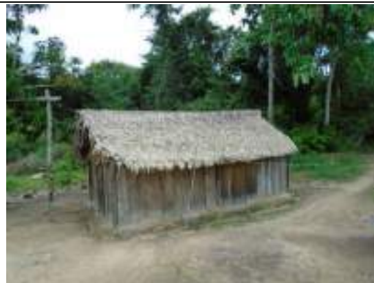
Foto 10: Construção de tábuas coberta com palha de babaçu na Terra Vista Alegre, localidade não contemplada com casas de alvenaria pelos Programas Ambientais da UHE Belo Monte (25/01/2019).
