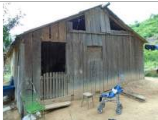
Foto 12: Frente da casa de José Dias de Sousa (25/01/2019) em localidade não contemplada com casas de alvenaria pelos Programas Ambientais da UHE Belo Monte.
