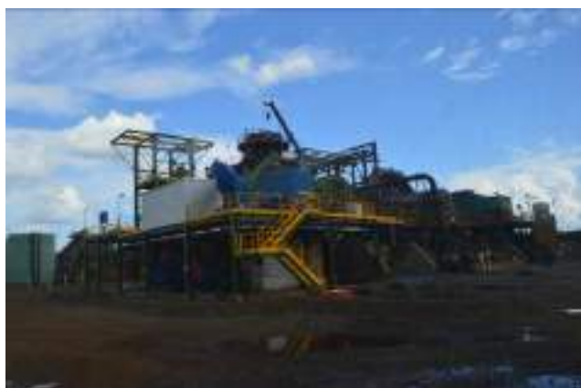
Foto 09: Visita à Mina Tucano – estruturas (25/07/2019).
