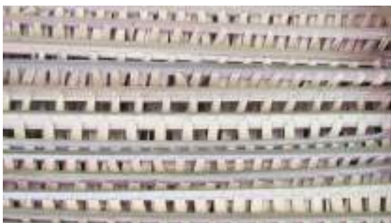
Foto 25: Detalhe da cobertura da casa do guerreiro da aldeia Guary-Duan, feito com olho da palha de babaçu.
