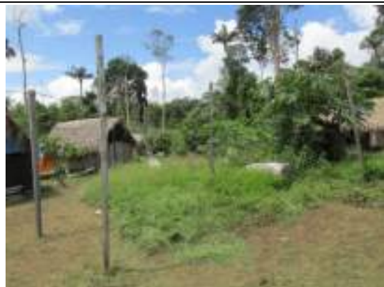
Foto 05: Residência em construção – aldeia Itkoum (26/01/19).
