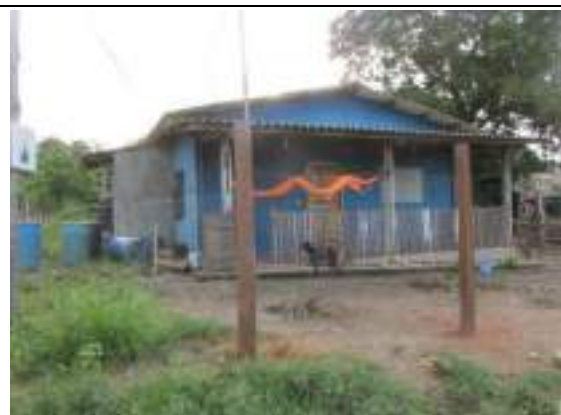
Foto 01: Residência – aldeia Terrawangã (23/01/19).
