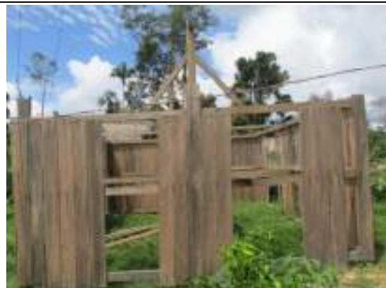
Foto 06: Farmácia em construção – aldeia Itkoum (26/01/19).
