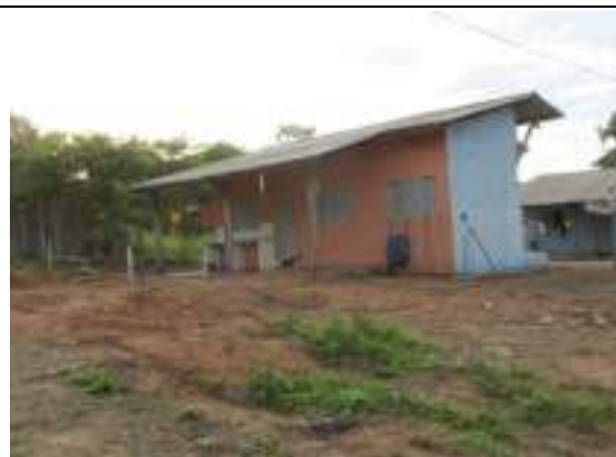
Foto 02: Residência – aldeia Terrawangã (23/01/19).
