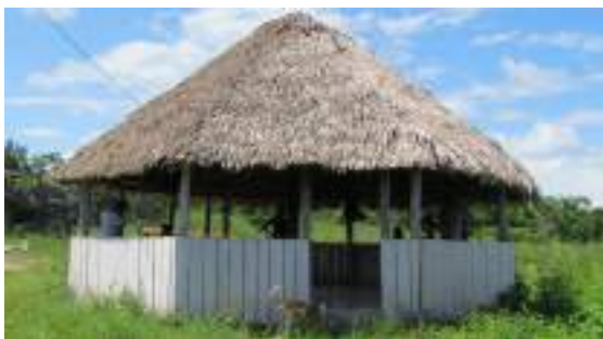
Foto 13: Casa do guerreiro da aldeia Guary-Duan, com tábuas de castanheira e cobertura de palha de babaçu (29/01/2019).
